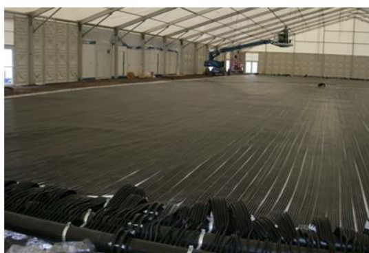
Verlegung des EPDM-Mattenfeldes in einer Eissporthalle
